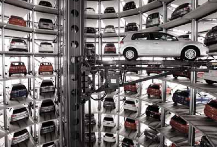
Torre de aparcamiento automatizada en la factoría Volkswagen en Wolfsburg, Alemania.
